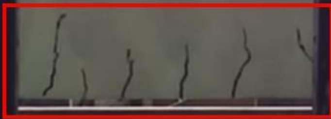
Fissuras de tração
